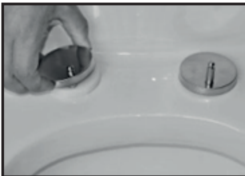
5. Coloque a tampa de aço inóx sobre os parafusos.
