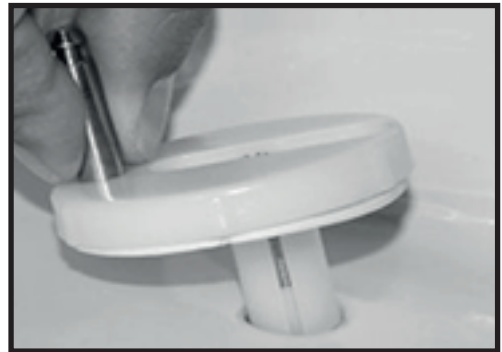
2. Coloque o parafuso no buraco de fixação.
